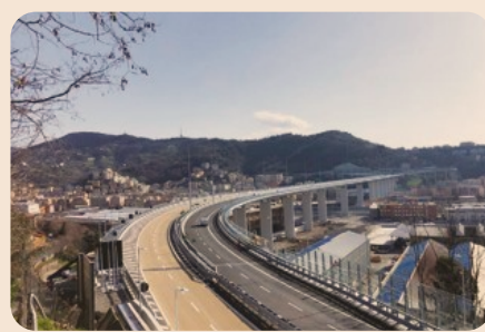
Nuovo "Ponte Genova San Giorgio", (Italia) - Fornitura ritegni sismici e guide prismatiche
