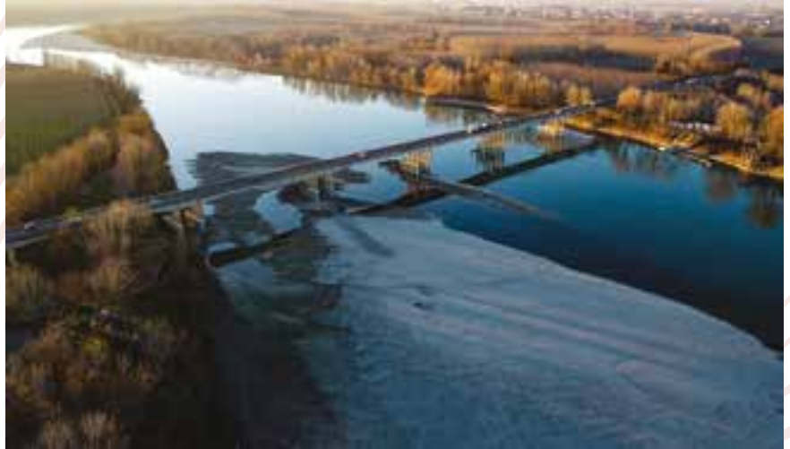
Infrastruttura Stradale - Ponte su Po (RE)
